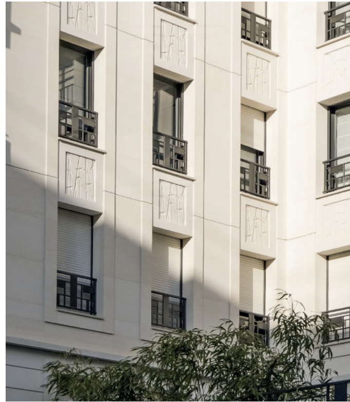
Ornementation au pourtour des baies en béton teinté dans la masse
