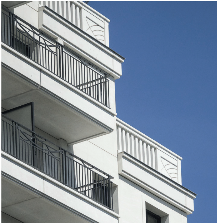
Balcon béton préfabriqué
