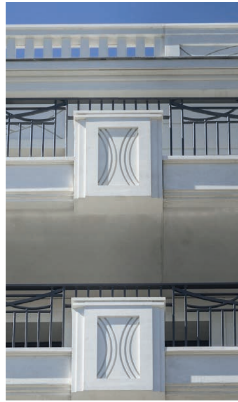
Ornementation béton teinté dans la masse
